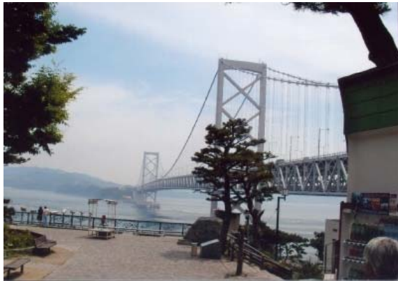
鳴門海峡大橋 1
