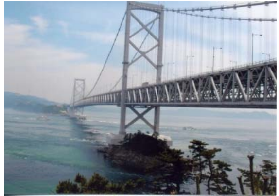
鳴門海峡大橋 2
